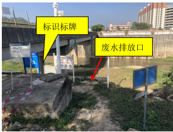
废水排放口及标识标牌
