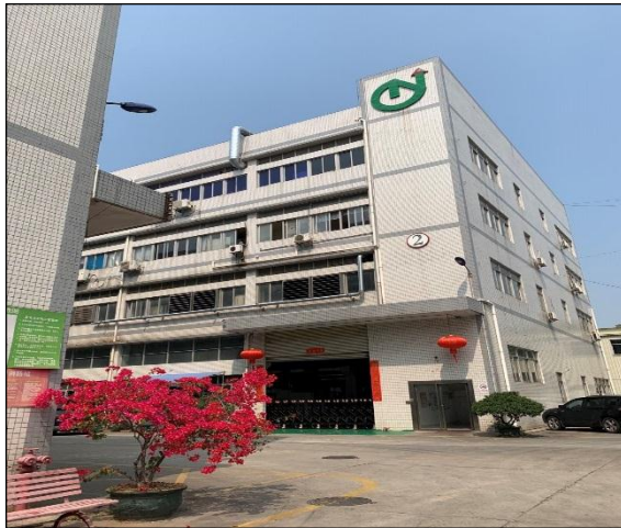
项目北面工业厂房
