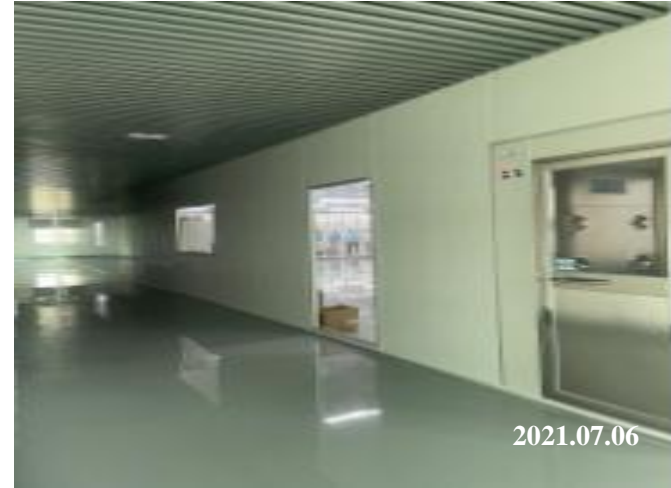
项目车间内现状
