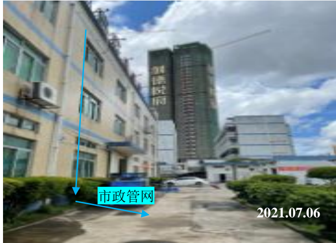
项目厂房外观
