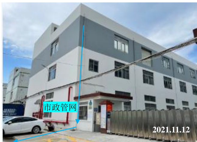
项目厂房外观
