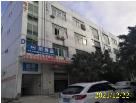
项目 B 栋厂房东面工业厂房
