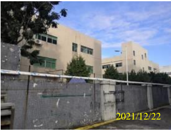
项目 A 栋厂房西面工业厂房
